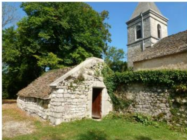
Cellier - Vue générale
