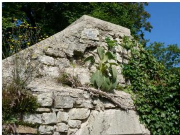
Cellier - Détail du pignon Est
