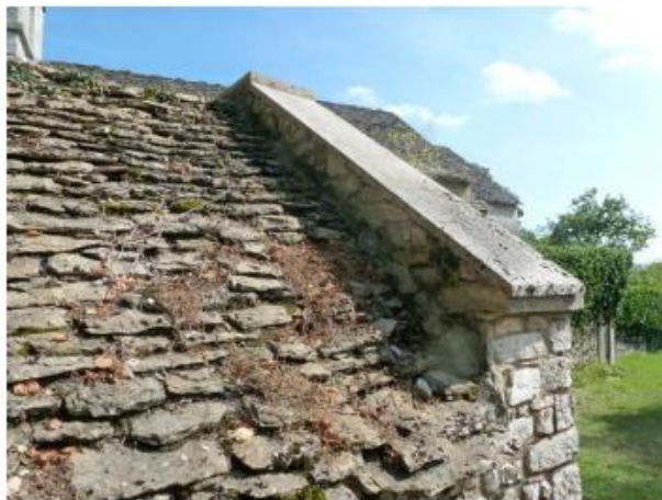
Cellier - Détail de la couverture et de la couvertine béton du pignon Est
