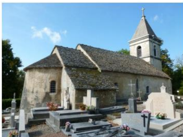
Chapelle - Façades Nord-Est. On distingue la mousse sur les lauzes
