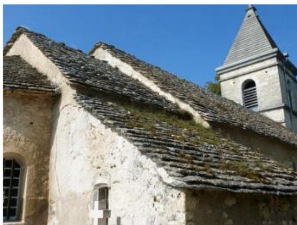
Chapelle - Détail des couvertures fortement végétalisées
